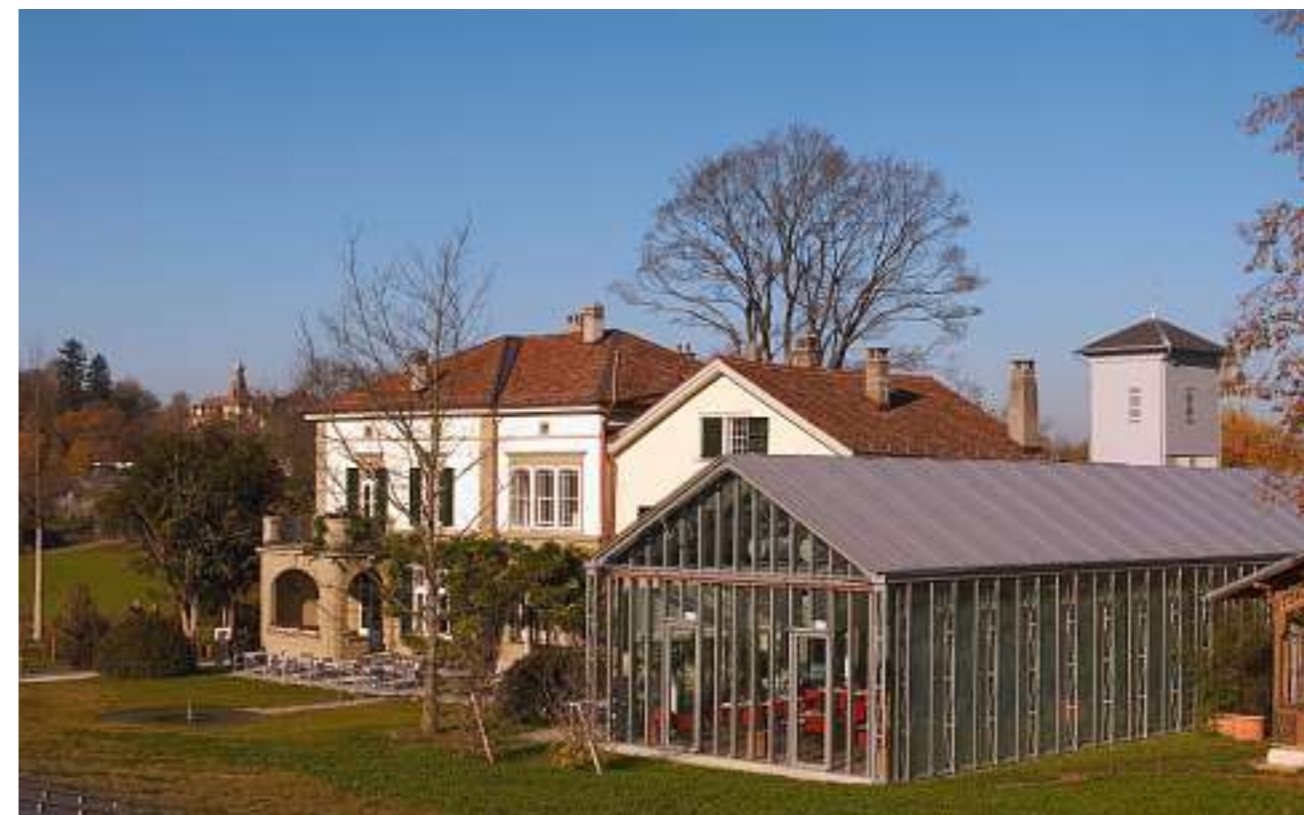
Blick auf die herrschaftliche, in einem Park gelegene Berner Villa Schöngrün mit dem modernen Restaurantanbau aus Stahl und Glas.
